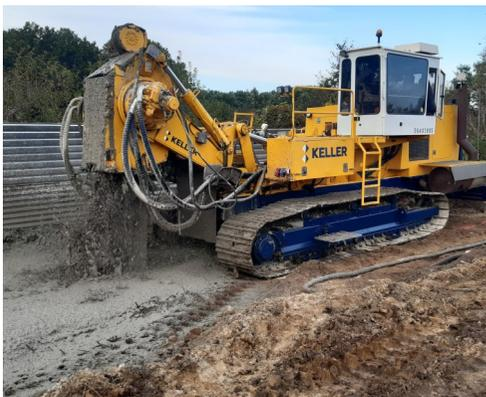
Les écrans étanches seront réalisés en utilisant la technique innovante du « mélange en place ».
